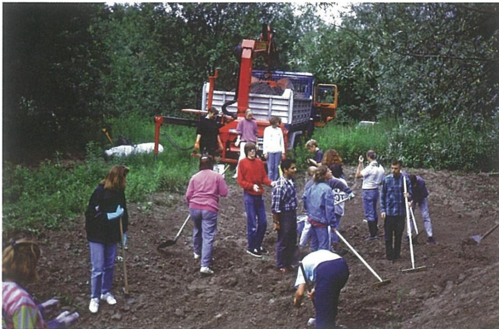
Anlage von Flachwasserteichen im Biotop Alte Rüttenen
