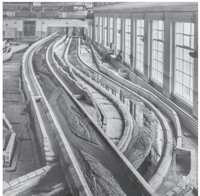
Schon beim Bau des heutigen Rheins wurden Modellversuche durch die ETH Zürich durchgeführt. (Modellversuche zum Rhein 1938), (c) Versuchsanstalt für Wasserbau, ETH Zürich
