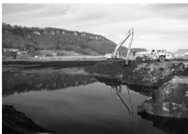
Hochwasserprojekt Egelsee im Bau
