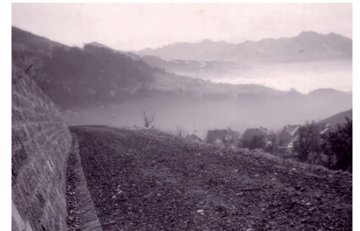
Morgengabeweg im Bau
