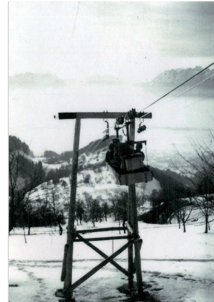
Drahtseilbahn von Weiler nach Fraxern
